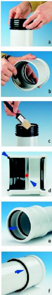
Рис. 37: Установка соединения с насадной муфтой
